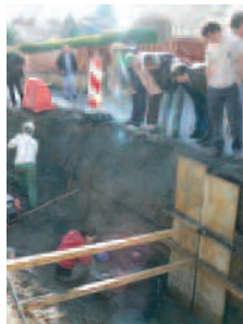
Fouilles rue Jean-Jaurès en 2007.
