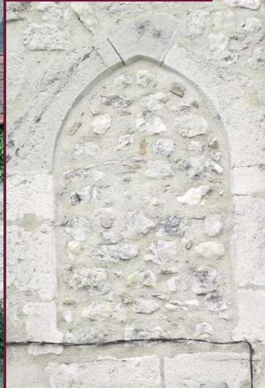
Baie en arc brisé à clef et ébrasée
