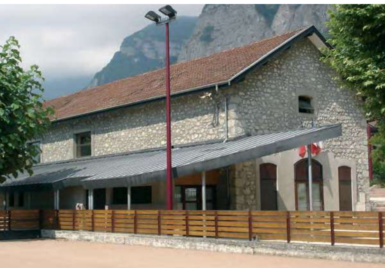
Ancien dépôt des wagons du tramway, puis première salle des fêtes de Crolles en 1930
