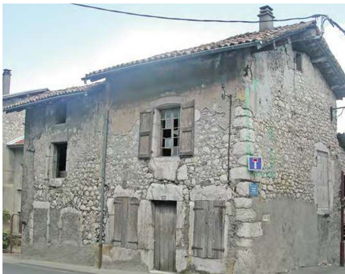
Exemple d'architecture rurale : porte pleine à lames, encadrement de pierres, volets à cadre et fenêtres à carreaux du XVIIIe siècle, traces d'enduit beige-rosé, tuiles canals
