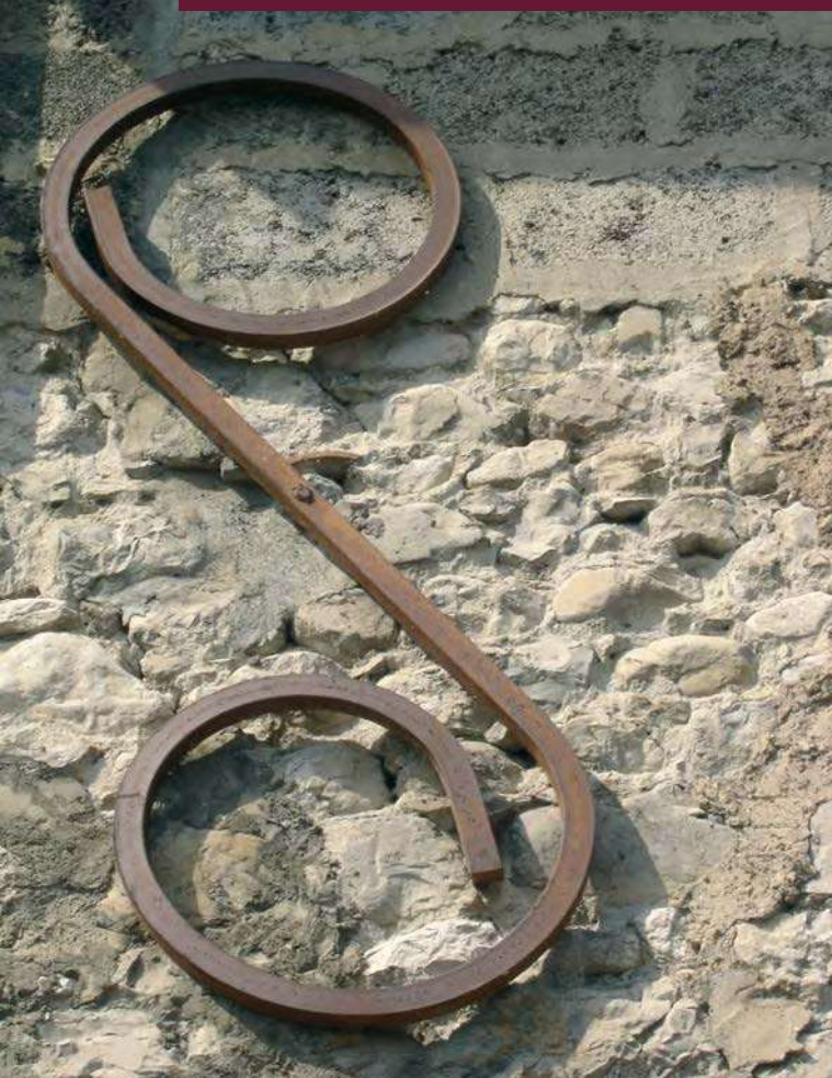
Porte de cave avec encadrement en pierre (XVIII e siècle) Tirant servant à maintenir la structure des murs
